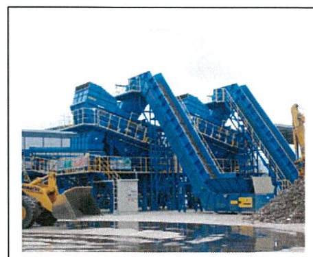
がれき処理プラント（破碎・分別）
