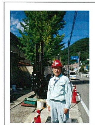
甲府でボーリング調査
